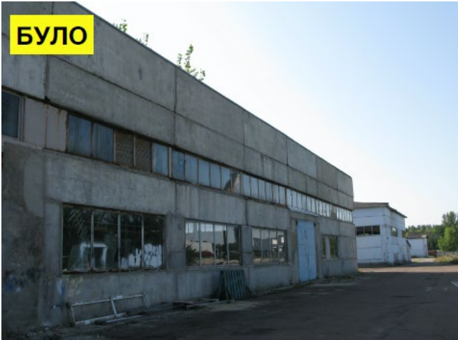
Будівля корпусу Дорожньо-експлуатаційного управління
